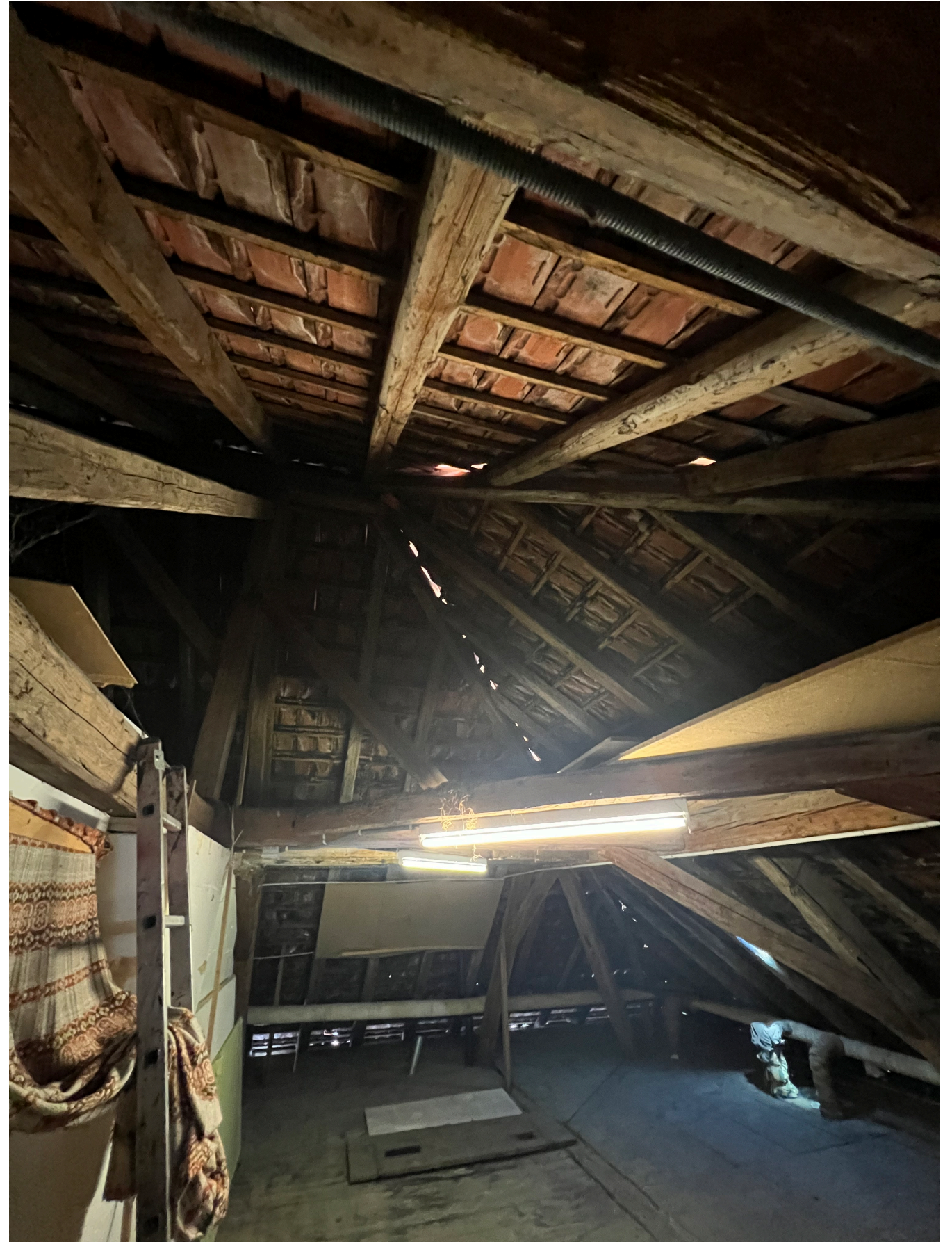
auberge "saint-pierre" - combles
